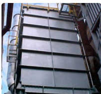
Filtros de Mangas para o segmento do Vidro, Mangas para Altas Temperaturas – até 250 °C
