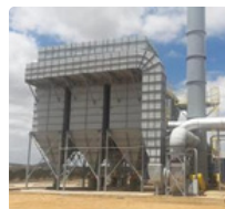
Filtros de Mangas "High Efficiency Particulate Air" Emissões até 0,03 mg/Nm 3
