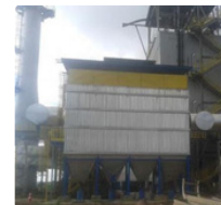
Filtros de Mangas para o segmento de Caldeiras, Mangas com \varnothing 160 mm x 6.000 mm
