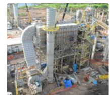
Filtros de Mangas para o segmento do Cimento, Mangas com \varnothing 150 mm x 6.000 mm
