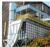
Filtros de Mangas para Fornos de Indução, Mangas com \varnothing 127 a 150 mm x 6.000 mm
