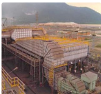
Filtros de Mangas para o segmento Siderúrgico, Mangas com \varnothing 150 mm e comprimento até 8.000 mm
