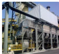
Filtros de Mangas série LHS: entrada de gases ao longo das mangas, filtragem pós finos e leves com limpeza ON / OFF LINE
