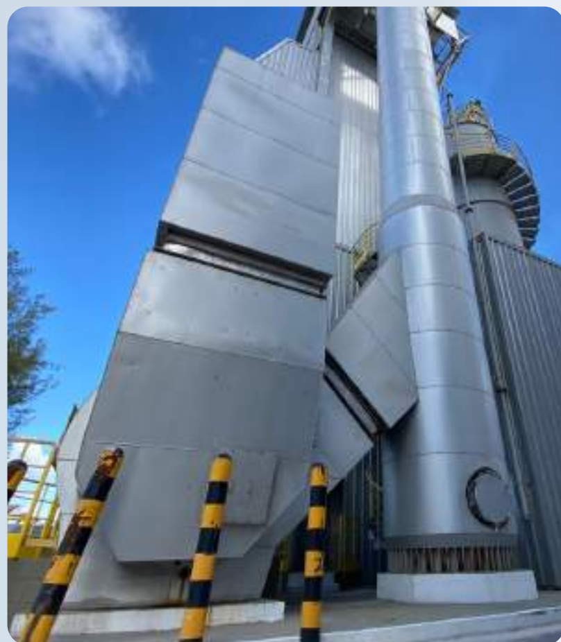
VENTILADOR PARA O DESPOEIRAMENTO DO FORNO DE VIDRO
