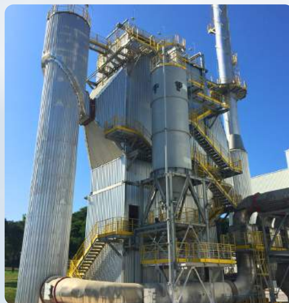
DESPOEIRAMENTO PARA FORNO DE VIDRO COM TORRE DE REAÇÃO - \text{Ca}(\text{OH})_2
