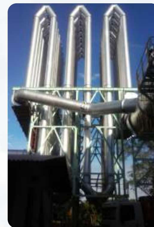
DESPOEIRAMENTO FORNO DE SILÍCIO METÁLICO
