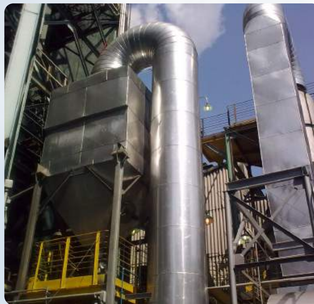
DESPOEIRAMENTO DE RESFRIADOR ROTATIVO DA USINA DE CALCIFICAÇÃO DE COQUE
