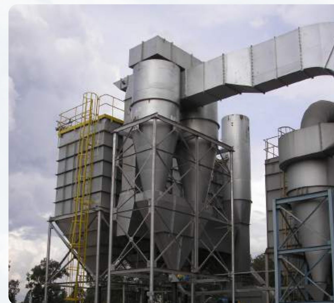
DESPOEIRAMENTO PARA FORNOS DE INDUÇÃO ABB
