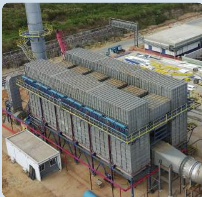
FILTRO PARA ÓXIDO DE CHUMBO Garantia de Emissão: 0,03\text{ mg}/\text{Nm}^3
