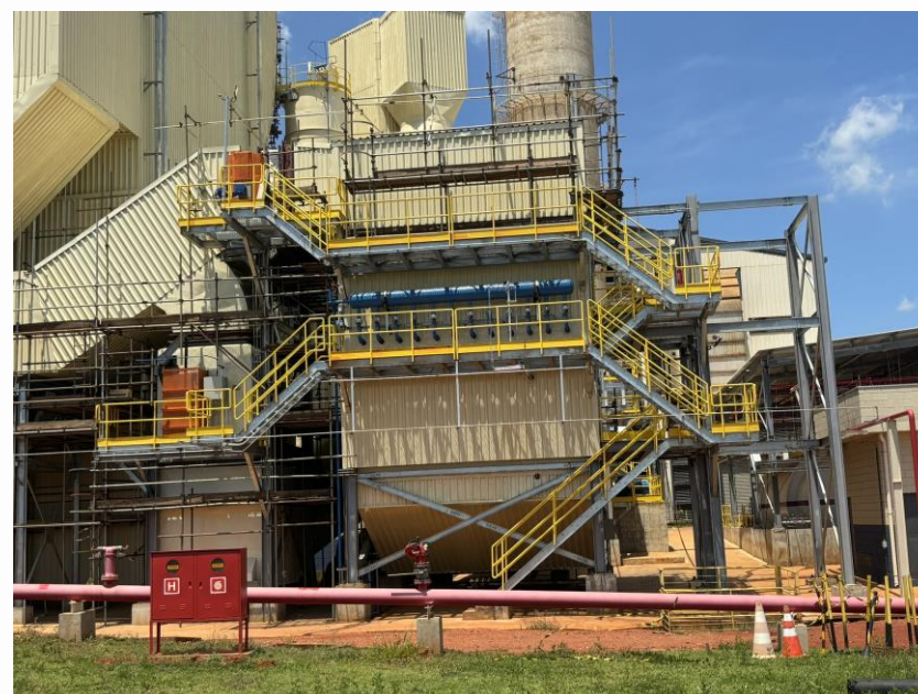
Forno de Vidro DE-NOx SCR Remoção Catalítica
