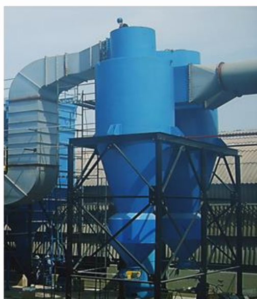
Forno Rotativo RB4 e RB5 Ciclone Defagulhadores Modelo 995 VM 810 / 150
