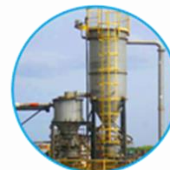
Transporte Pneumático Fase Diluída - Cinzas
