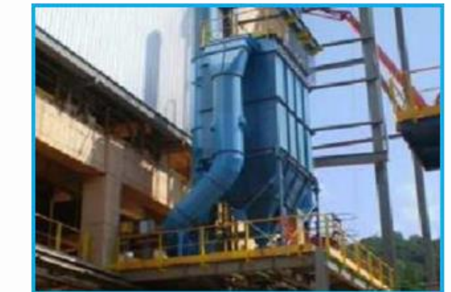
Despoeiramento para Pilha de Estocagem de Minério Britado
