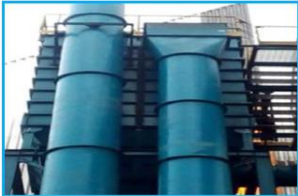
Despoeiramento na Armazenagem de Açúcar
