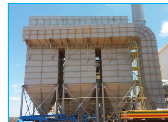
Filtro Absoluto para Óxido de Chumbo - Filtro de Mangas com Construção Integrada com Filtros HEPA
