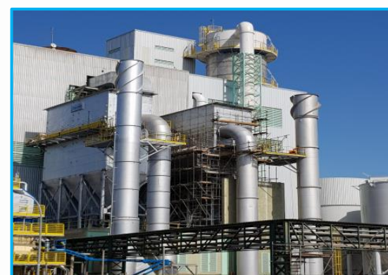
Despoeiramento para Torre de Secagem (Spray Dryer) - Detergente em Pó
