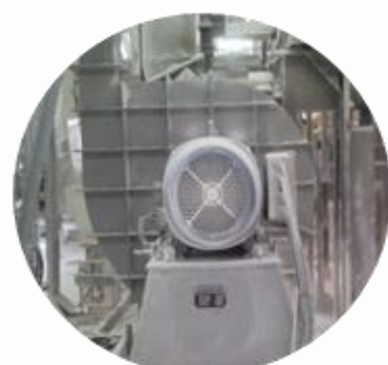
Processo de Drywall
