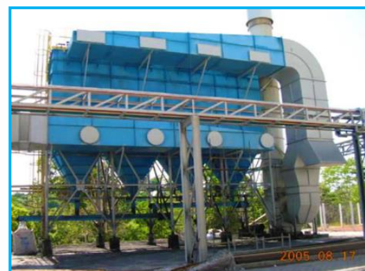
Despoeiramento para Planta de Fusão de Alumínio
