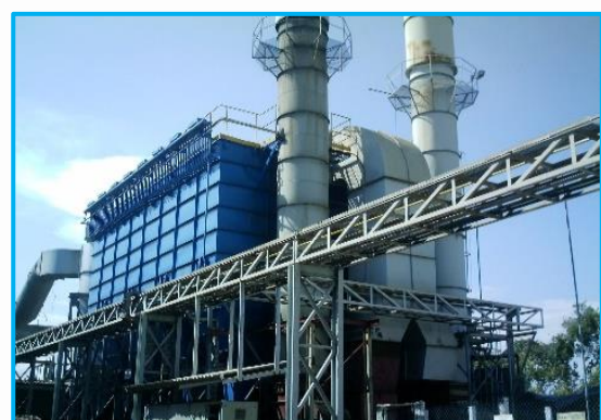
Despoeiramento para Planta de Fusão de Alumínio
