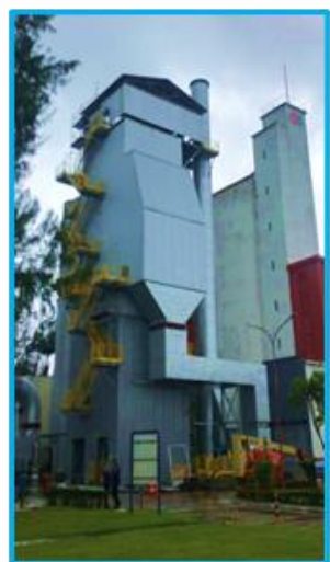
Despoeiramento em Forno de Vidro
