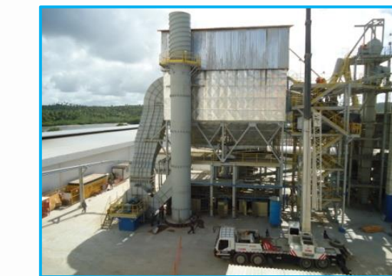
Despoeiramento para Produção de Cimento - Filtro de Processo
