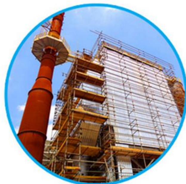
Obras Civis, Montagens Eletromecânicas e Start Up
