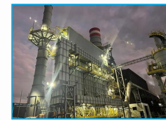
Despoeiramento para Topo do Alto Forno - Siderurgia
