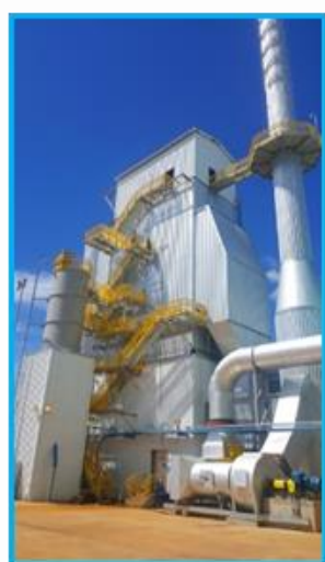
Despoeiramento em Forno de Vidro
