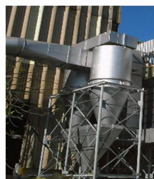
Forno de Indução Ciclone Defagulhador Modelo 995 VM 810 / 150
