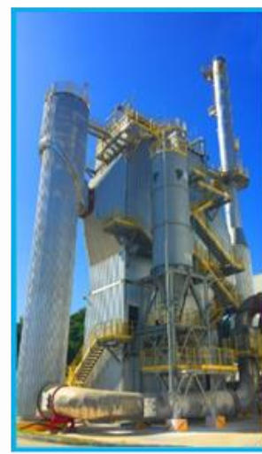
Despoeiramento em Forno de Vidro
