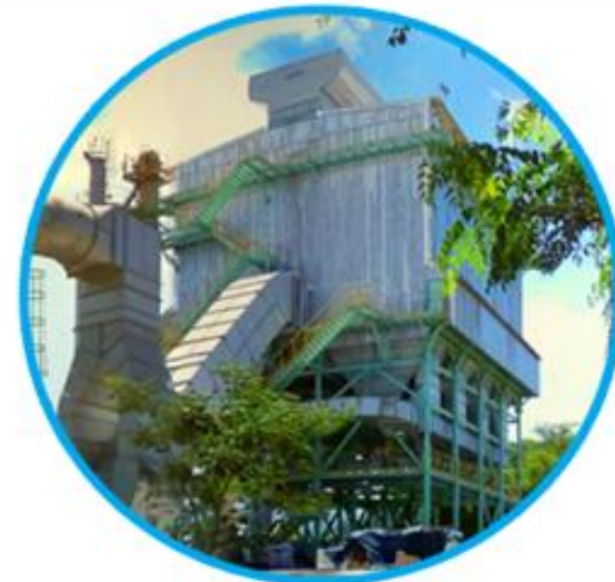
Filtros de Mangas
