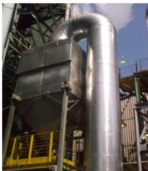
Caldeira de Coque Multiciclone Modelo VHF 56-9
