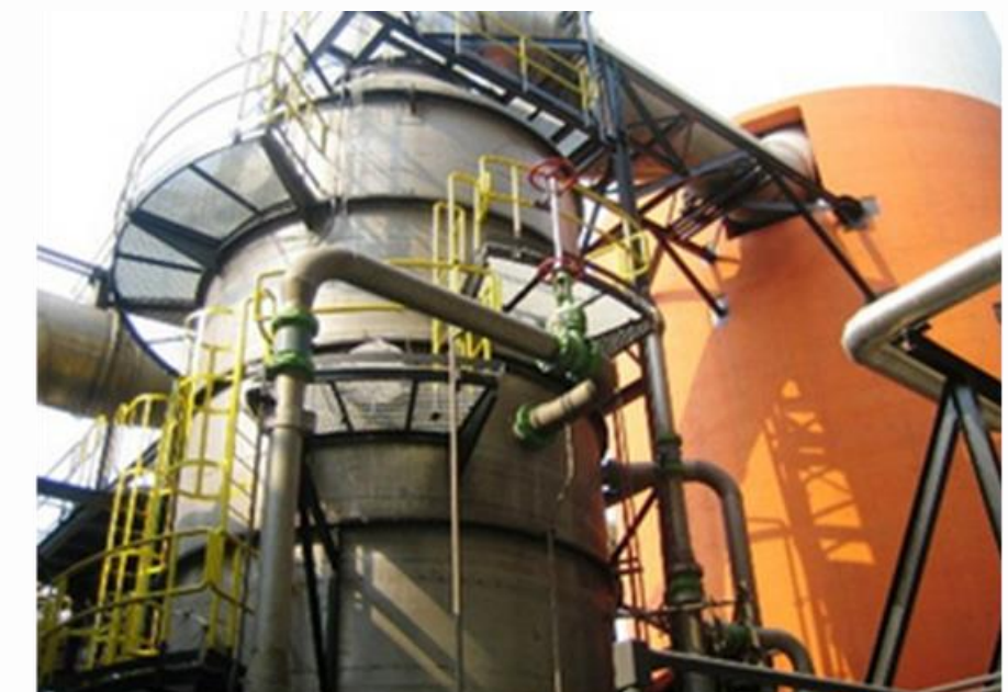
Caldeira (Papel & Celulose) Lavador de Gases Via Úmida, com NaOH como reagente.
