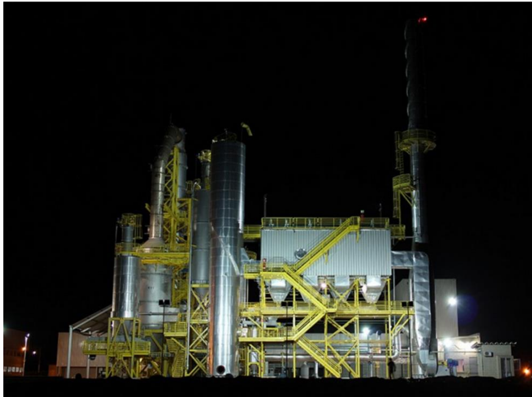
Remoção e Tratamento de Gases Ácidos em Planta de Incineração de Resíduos Perigosos
