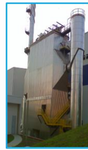
Despoeiramento em Forno de Vidro
